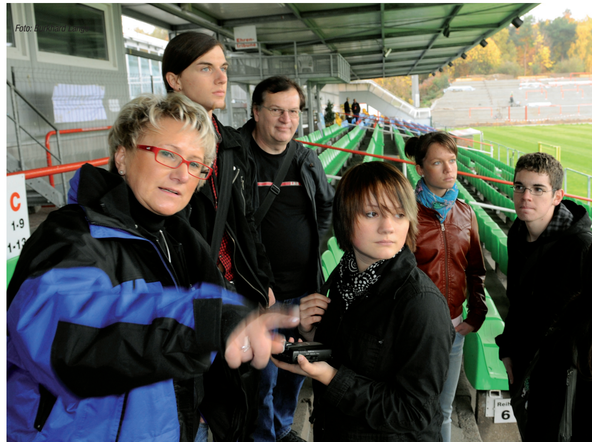
Projektleiterin Sylvia Weisheit (l.) führt die jungen Reporter über die Baustelle des neuen Union-Stadions.
